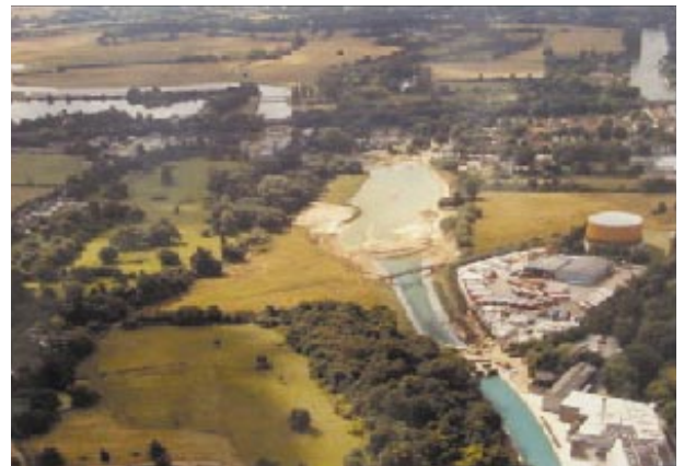
写真 - 1 建設中のJubilee放水路
