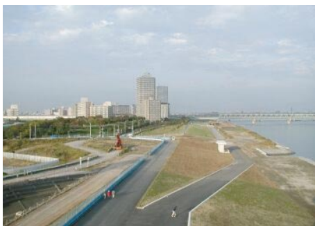
写真-2 高規格堤防と緊急河川敷道路 （荒川下流部 小松川地区）
