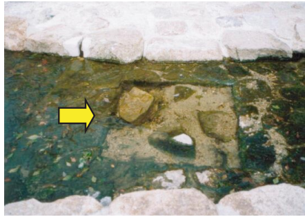
写真-3 取水ピット（神戸市の住吉川） 河床に掘られた穴（矢印）によって取水が可能となる水深を確保します。撮影時には土砂が溜まっていたが、使用時には土砂を除去します。
