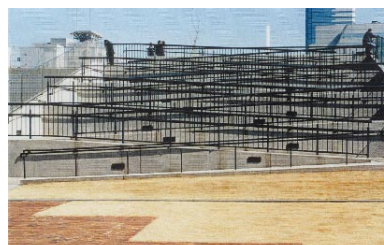
写真 - 1 高低差が大きくても通常と同様に処理すると、まるで柵の展示会のようになってしまう
