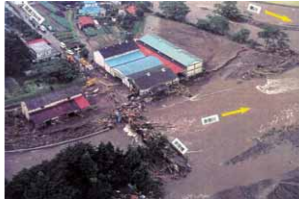
写真-1 余笹川洪水氾濫による国道294号切断と氾濫原・河道地形の変化
