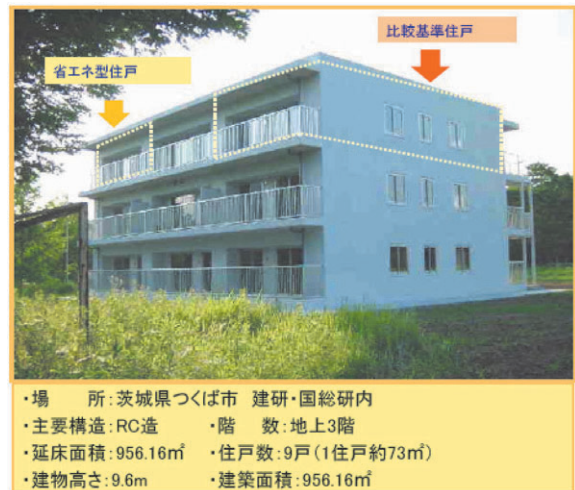
図-1 省エネルギー性能に関する実証実験を実施中の研究用建物（9区画のうち、最上階両妻側の区画を使用）
