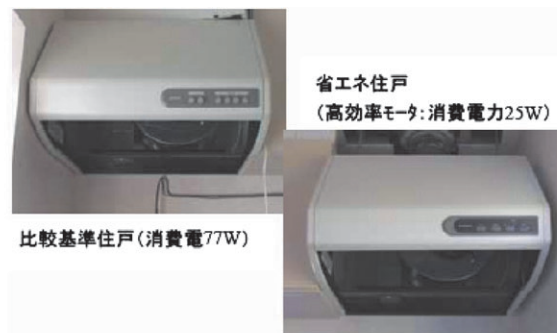
図-4 (4) 比較基準住戸と省エネ住戸に設置された換気設備の一部
