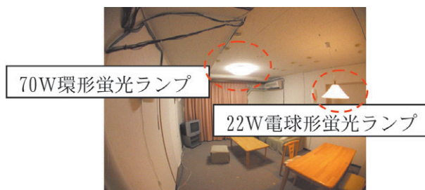
写真-1 一室一灯例 (リビング・ダイニング)
