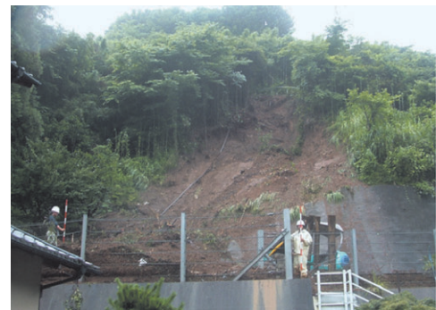
図-1 丸子井尻地区で発生したがけ崩れの様子
