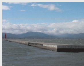
写真-2 函館港防波堤(被災前)
