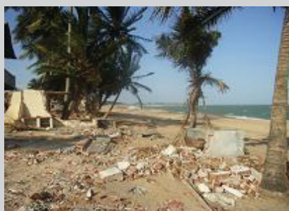
写真－1 沿岸域の被災（スリランカ）
