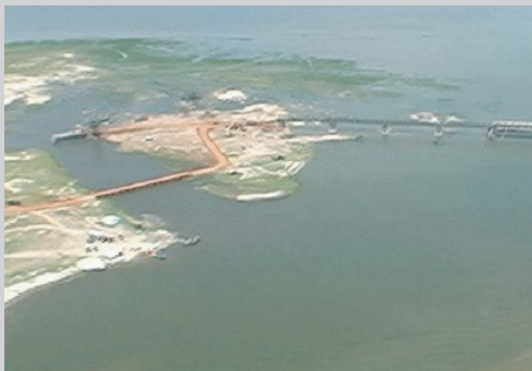
写真－3 道路橋 Arugam Bay bridge
