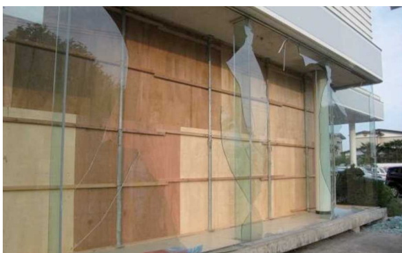
写真 面外方向の影響が想定される被害例
