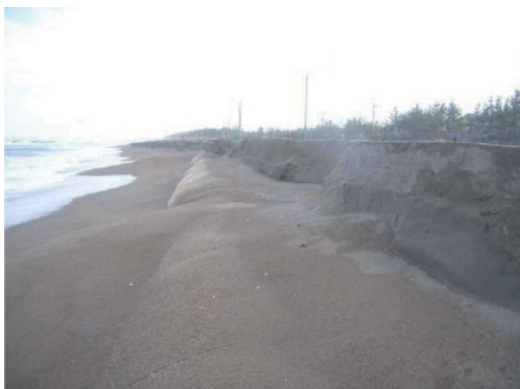
写真-1 砂浜になじむ浜崖後退抑止工(浜住海岸)
