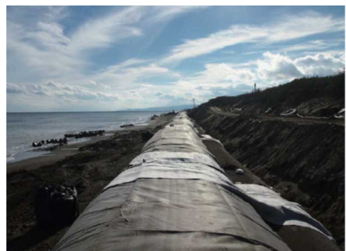
写真-2 宮崎海岸で採用された浜崖後退抑止工
