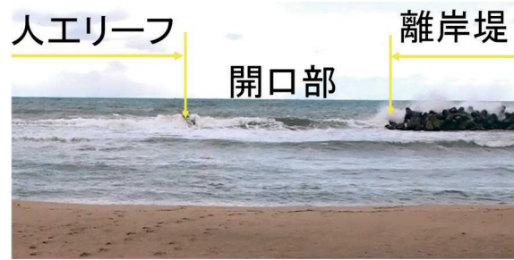
写真-1 人工リーフによる消波(皆生海岸)
