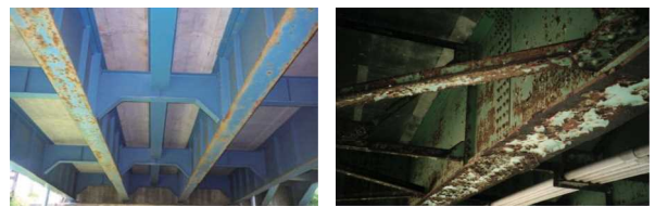
(a) 損傷程度の評価「b」 (b) 損傷程度の評価「e」
