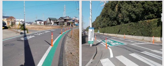
写真 交通安全対策実施後の状況
