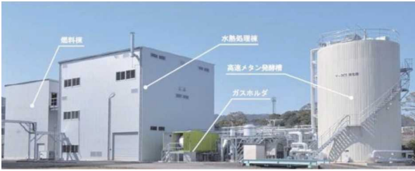
図一 1 実証施設の外観(長崎市東部下処理場)
