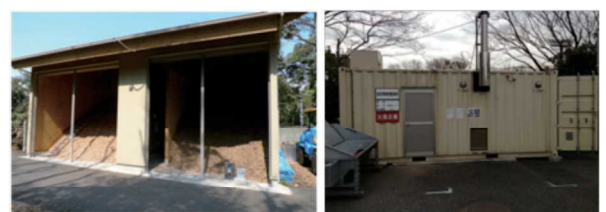
写真 公園の剪定枝を活用した園内施設熱利用 （大井ふ頭中央海浜公園：東京都） （左：太陽熱利用チップ乾燥施設 右：ボイラー）
