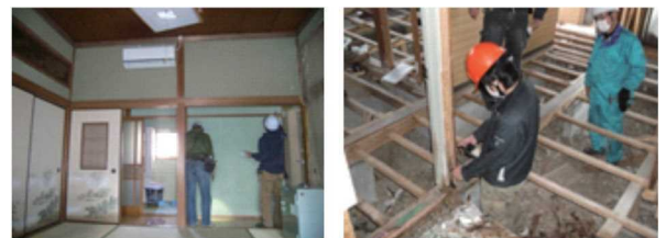
写真1 現況調査の実施状況 写真2 劣化調査の実施状況
