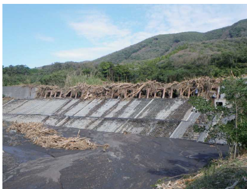
写真－3 砂防施設による土砂及び流木の捕捉 (大金沢本川堆積工)
