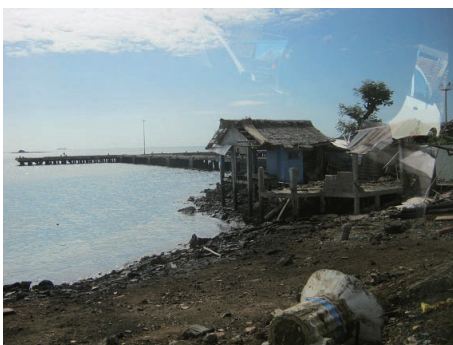
写真 台風1330号(Haiyan)によるフィリピン港湾の被災状況(エスタシア港) 1),2)
