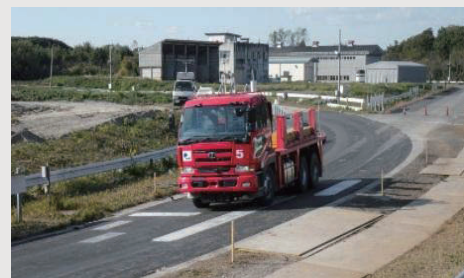
写真 電線等を埋設した舗装における車両走行実験
