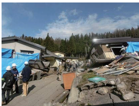
写真1 倒壊した住宅
