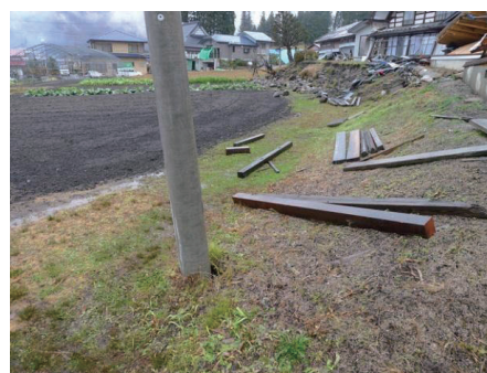
写真2 南向きに崩壊した石垣と傾斜した電柱
