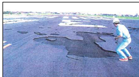
写真 プリスタリングに伴う大規模な破損
