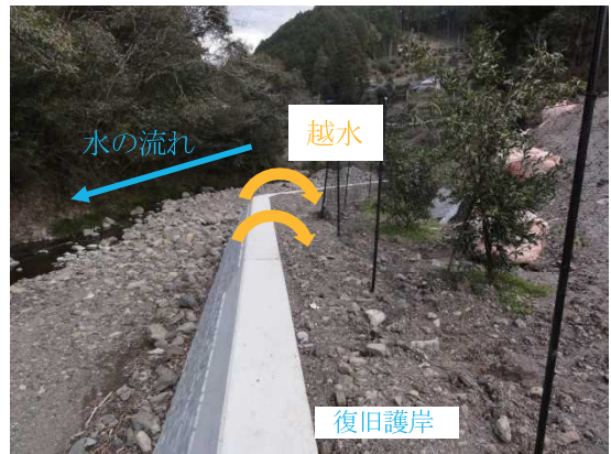
写真1：湾曲部内側における被害の復旧
