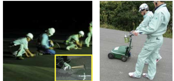
写真(左) 空港舗装の点検作業状況
