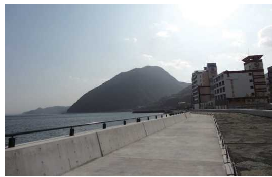
写真1 高潮対策で整備した護岸上がプロムナードとなっている事例(地域資源に対する新たな視点場となっている(別府港))
