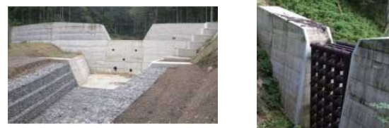
図2 砂防堰堤(左:不透過型、右:透過型)
