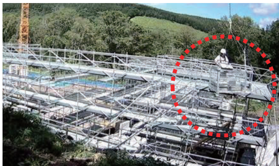
写真-2 カゴを用いた資材運搬
