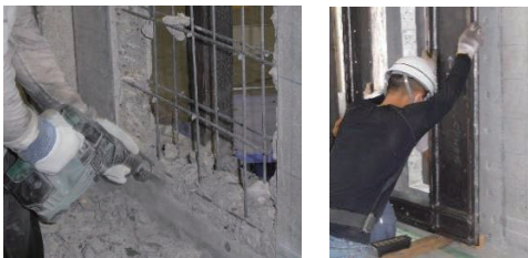
写真-1 開口の新設、補強を目的とした施工実験
