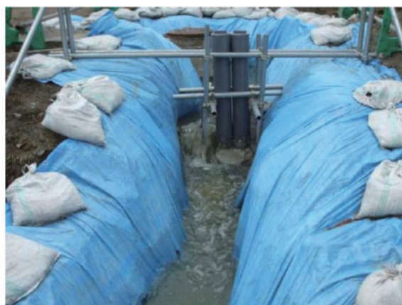
写 2 素掘水路で近傍水路へ導水した事例(青森県馬淵川流域) 1)
