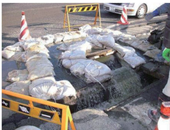
写 1 土嚢を使用し近傍水路へ導水した事例(宮城県多賀城市) 1)
