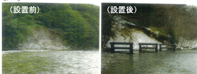
図-1 据置型の制御工の設置事例(梓川:上高地)
