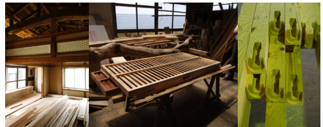
写真2 改修現場、改修用部材とプレカット部材
