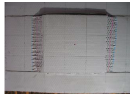
写真-4 押し抜き試験状況 (目地部)
