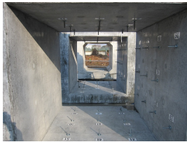
写真-2 模擬損傷供試体
