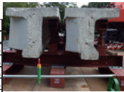
写真-4 撤去桁 (桁間隔 150mm)
