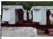
写真-5 撤去桁 (桁間隔 800mm)
