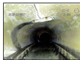
写真-1 偏平と破損の併発
