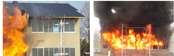
写真 1 防火壁を越えた延焼
