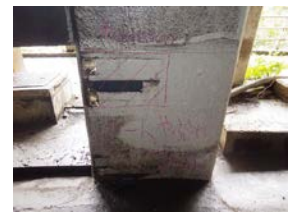
(a) 断面修復工(谷側柱)
