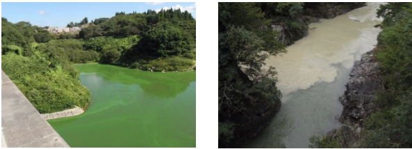
写真 1 ダム貯水池の水質変化現象の例 (左：富栄養化 右：濁水長期化)
