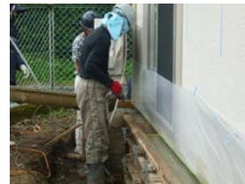
写真2 木造仮設住宅のRC基礎改修工事(阿蘇市) (熊本県提供)
