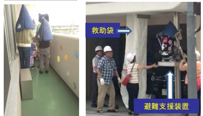
図5 避難訓練の実態調査による、救助袋と避難支援装置の避難時間の確認の様子
