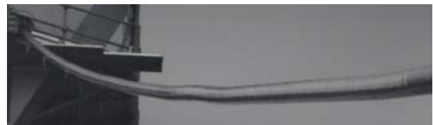
図-1 桑鶴大橋のケーブルの一部に生じたよれ
