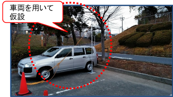
図-1 可搬型路側機の設置例(岡山県早島町)
