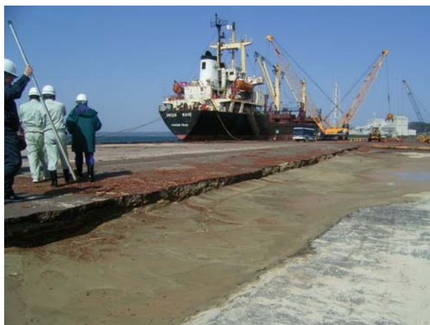
写真5 七尾港太田地区-10m岸壁(1号から2号岸壁) Photo 5. -10m Quaywall in the Ota District of Nanao Harbor (Quaywalls 1 to 2)
