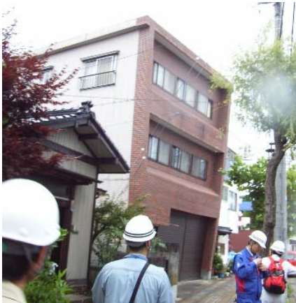
写真-5 大きく傾いた鉄骨造建築物 Photo 5. Steel-frame building leaning sharply
