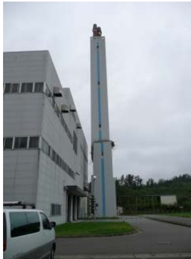
写真-6 大きな被害を受けた鉄筋コンクリート造の煙突 Photo 6. Severely damaged reinforced concrete chimney
