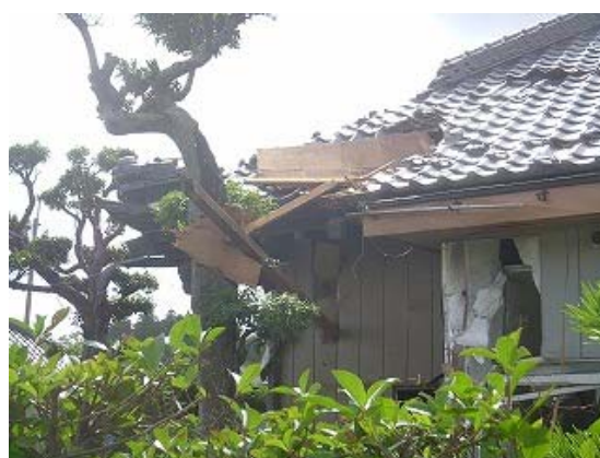
写真6 飛来物による被害（土浦市） Photo 6 Debris impact on envelopes (Tsuchiura city)
