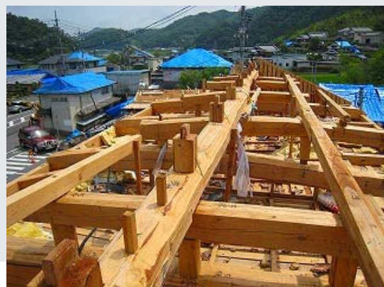
写真 2 被害状況の詳細
