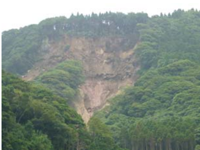
写真-1 船石川崩壊地
