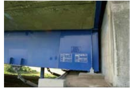
写真-1 部分塗替え塗装後
