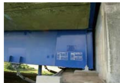
写真-1 部分塗替え塗装後
