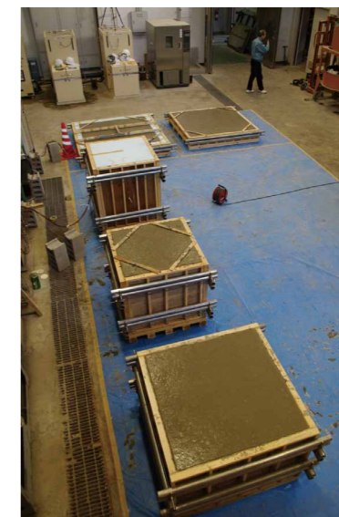
写真 1 作製中の実大試験体
