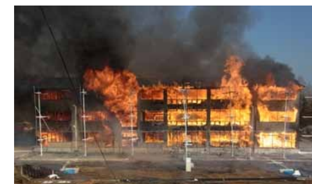
建物全体に火災が拡大した点火後34分時点の様子
