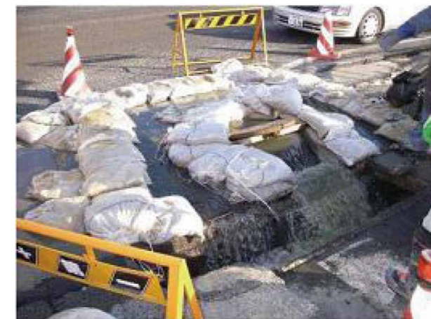
土のうを使用し近傍水路へ導水した事例
