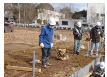
塩ビ管の施工状況
