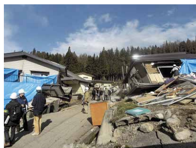
写真 倒壊した住宅
