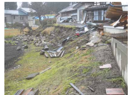
写真 崩壊した石垣
