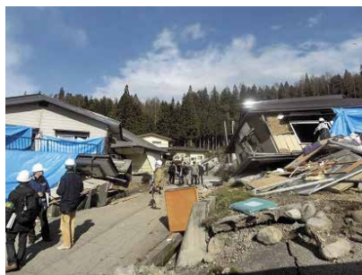
写真 倒壊した住宅
